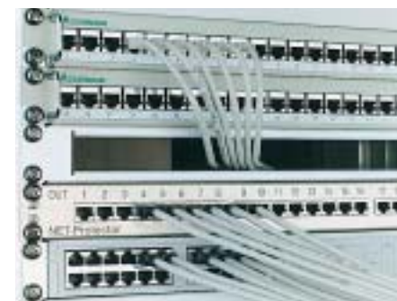
NET-Protector 4TP Le Net-Protector est installé au moyen d'un câble de brassage entre le hub et le panneau de brassage. Les connecteurs d'entrée sont également des connecteurs RJ45.
