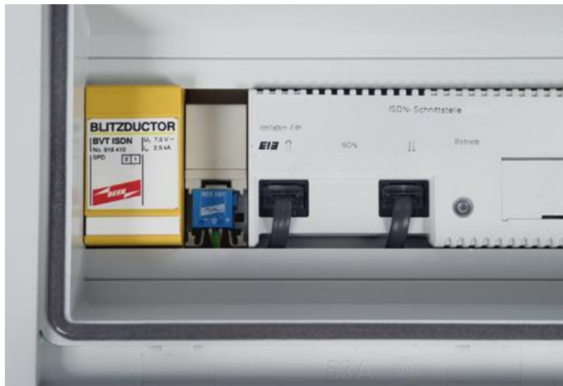
Figuur 4 - installatievoorbeeld EIB Bustector op ISDN interface
