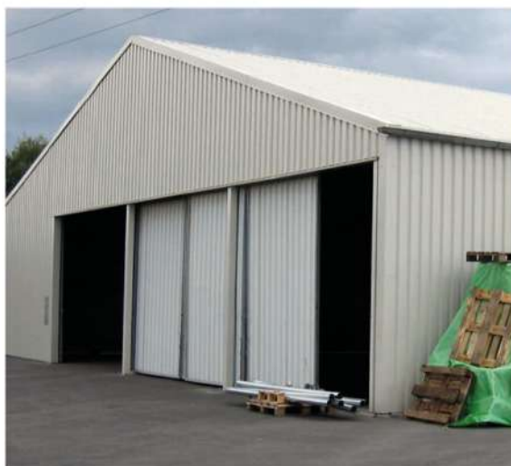
Afbeelding 4 metalen loods met metalen gevelbekleding
