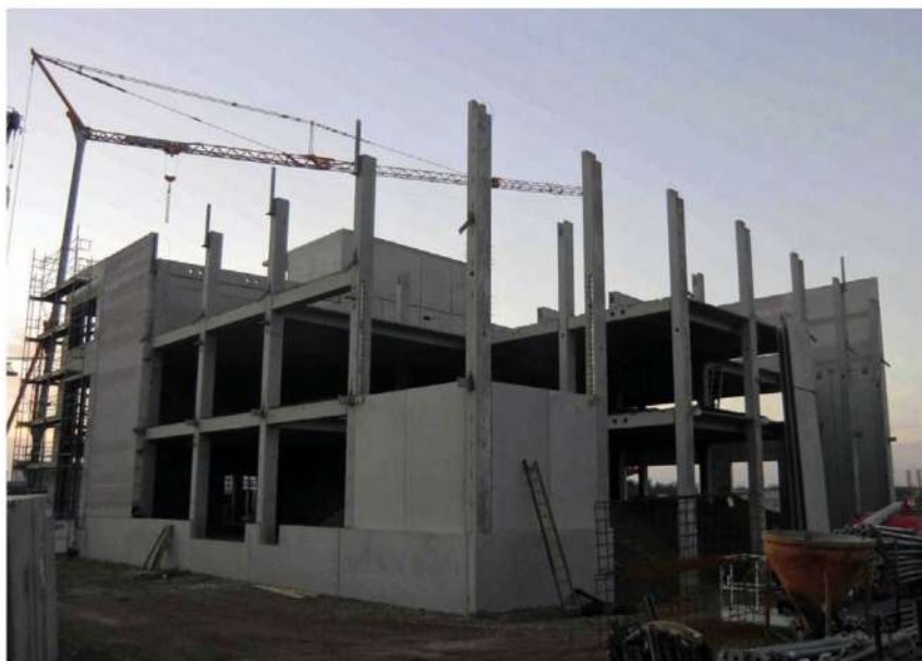
Afbeelding 1 gewapende betonnen kolommen als natuurlijke daalgeleider
