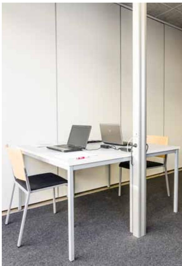
Ces colonnes de distribution sont tendues entre le sol et le plafond architectural. Les câbles d'alimentation sont introduits dans la colonne par le faux plafond afin de pouvoir l'alimentation à n'importe quelle hauteur. Ainsi, la colonne double peut pourvoir plusieurs postes de travail de raccords de données et de prises de courant fort. Les mécanismes 45x45 s'encliquettent simplement dans l'ouverture du couvercle.
