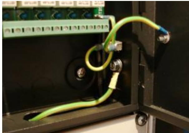
Figuur 2 : Details aansluiting aardingsklem MICROS+
