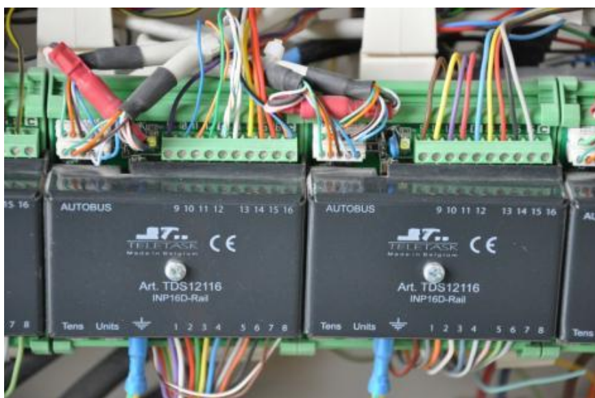
Figuur 30 : Voorbeeld aansluiting DIN rail modules
