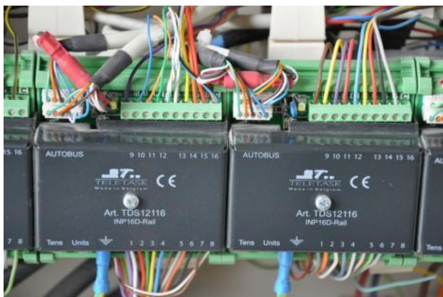
Figuur 30 : Voorbeeld aansluiting DIN rail modules
